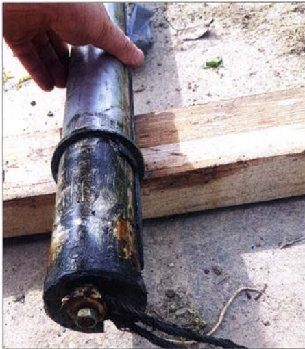
Bild 5: Unterstes Mastsegment separat
