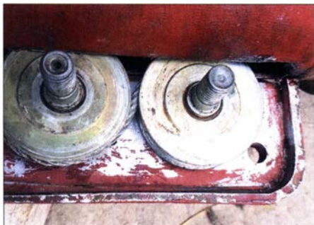
Bild 10: Einbau der Umlenkrollen
