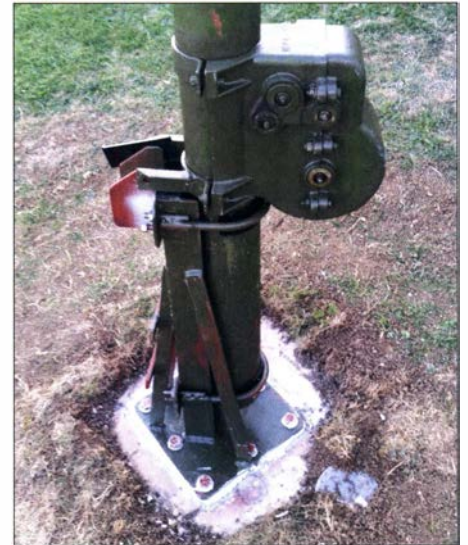
Bild 12: Hauptrohr mit Kurbelgehäuse – auf einem Betonsockel bei DG2SBW
